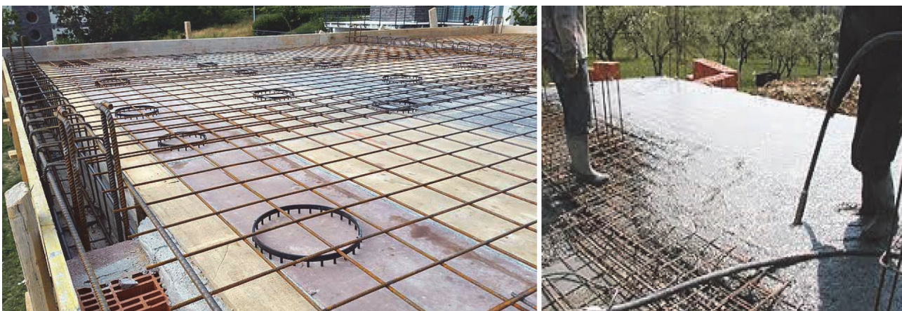
Slike 2.2. i 2.3. Izvedba "pune" AB stropne ploče (izvor: www.google.com)
